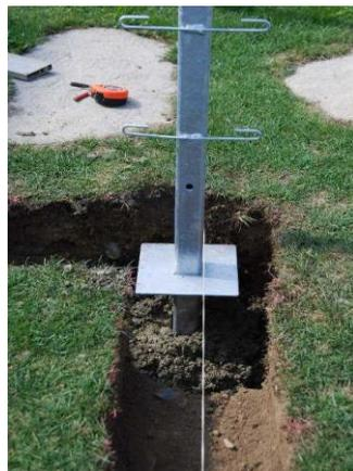
Bild: Ausrichtung mittels Schnur
