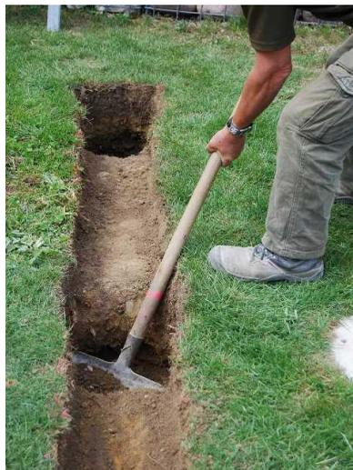
Bild: Aushub der Punktfundamente und der Sauberkeitsschicht
