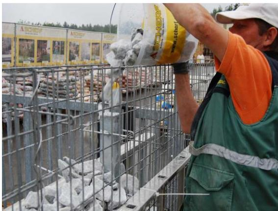
Bild: Befüllen der Gabione
