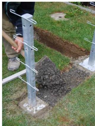
Bild: Verfüllen der Sauberkeitsschicht
