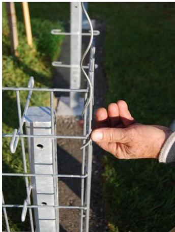
Bild: Eindrehen des Spiraldrahts
