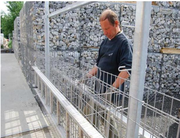
Bild: Befestigung von Leitern als Einfüllhilfe
