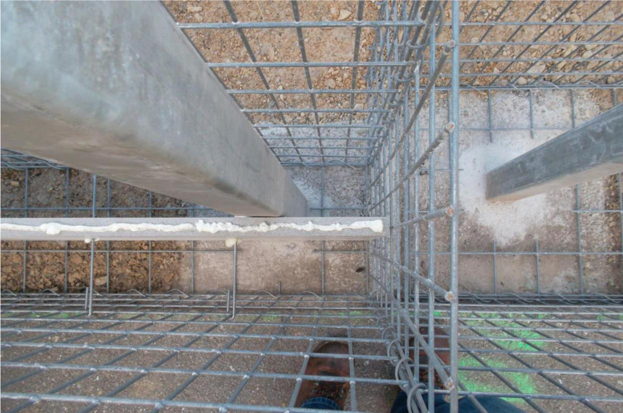
Bei der Mauertiefe 30 cm ist ab 1 m Höhe der Einbau von Stehern statisch notwendig.
