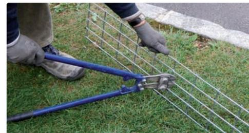
Die Zaunlänge ist durch einfaches Abwickeln der Matten in 5 cm Schritten anpassbar. Standardlängen: 30/50/100/150/200 cm
