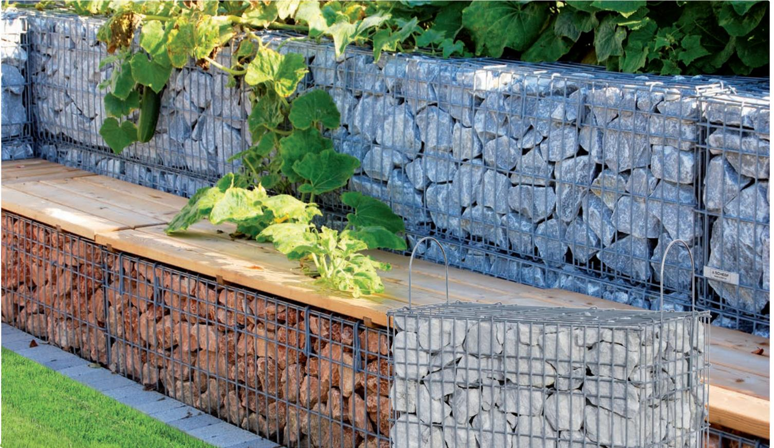
Die größeren Steine des gewählten Füllmaterials werden mit der flachen Seite am Gitter ausgerichtet. Durch diese anspruchsvolle Handarbeit erhält der Steinkorb die Optik eines engfugigen Zyklopenmauerwerkes. Die Berechnung erfolgt als Aufpreis pro m<sup>2</sup>. Jede Fläche kann als handgerichtete Sichtfläche ausgeführt werden.
