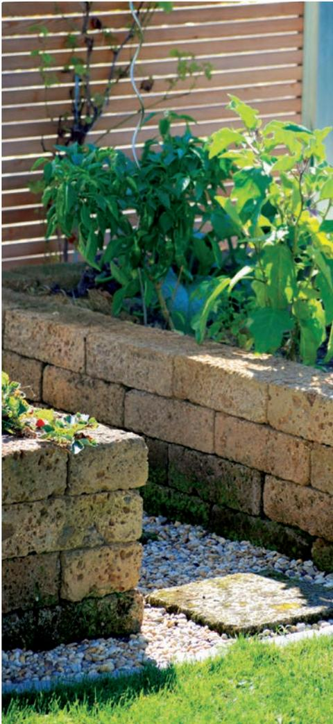
Der rotbraune Tuffstein ist ein vulkanischer Naturstein und besteht aus Sand, Lava, Bimsstein und Asche. Er ist sehr porös und hat eine warme Ausstrahlung. Bereits die Römer setzten den Tuffstein zum Bau von Villen, Bädern und Thermen ein. Im Mittelalter wurden damit Burgen und Städte gebaut. Heute wird er als Baustein in der Gartengestaltung verwendet:
