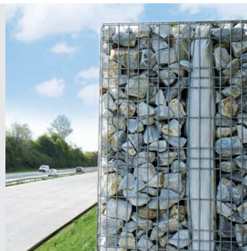
**VARIANTE 2****Selbstbau-Gabione mit Lärmschutzkit**
