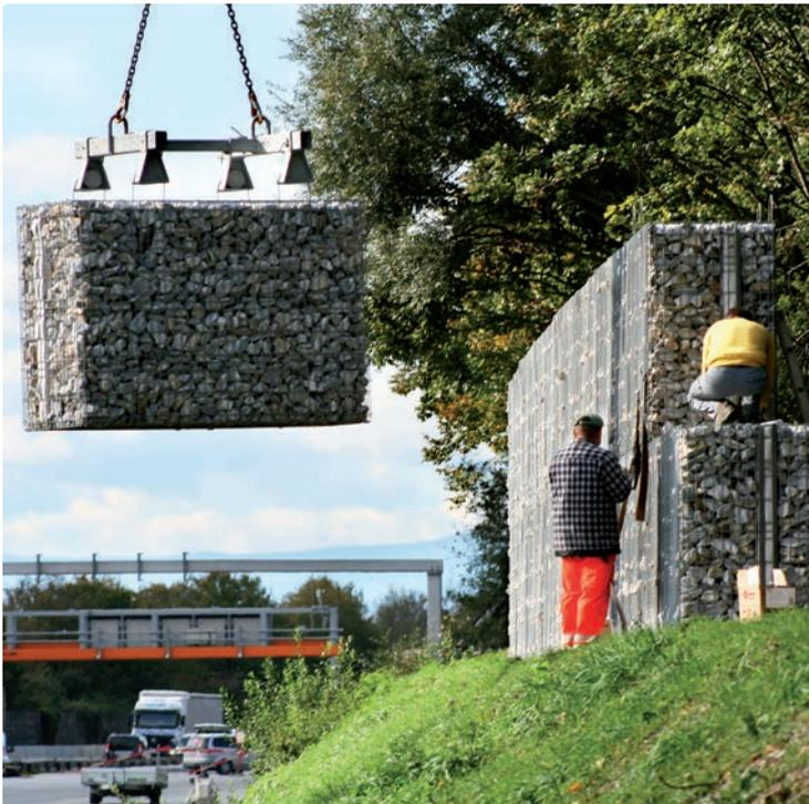
Gabionen, die ausschließlich mit Steinen befüllt sind, gewähren keinen effektiven Lärmschutz. Um die in den Normen geforderten Lärmschutzwerte zu erfüllen, ist der Einbau eines Lärmschutzkerns in den Steinkorb erforderlich.
