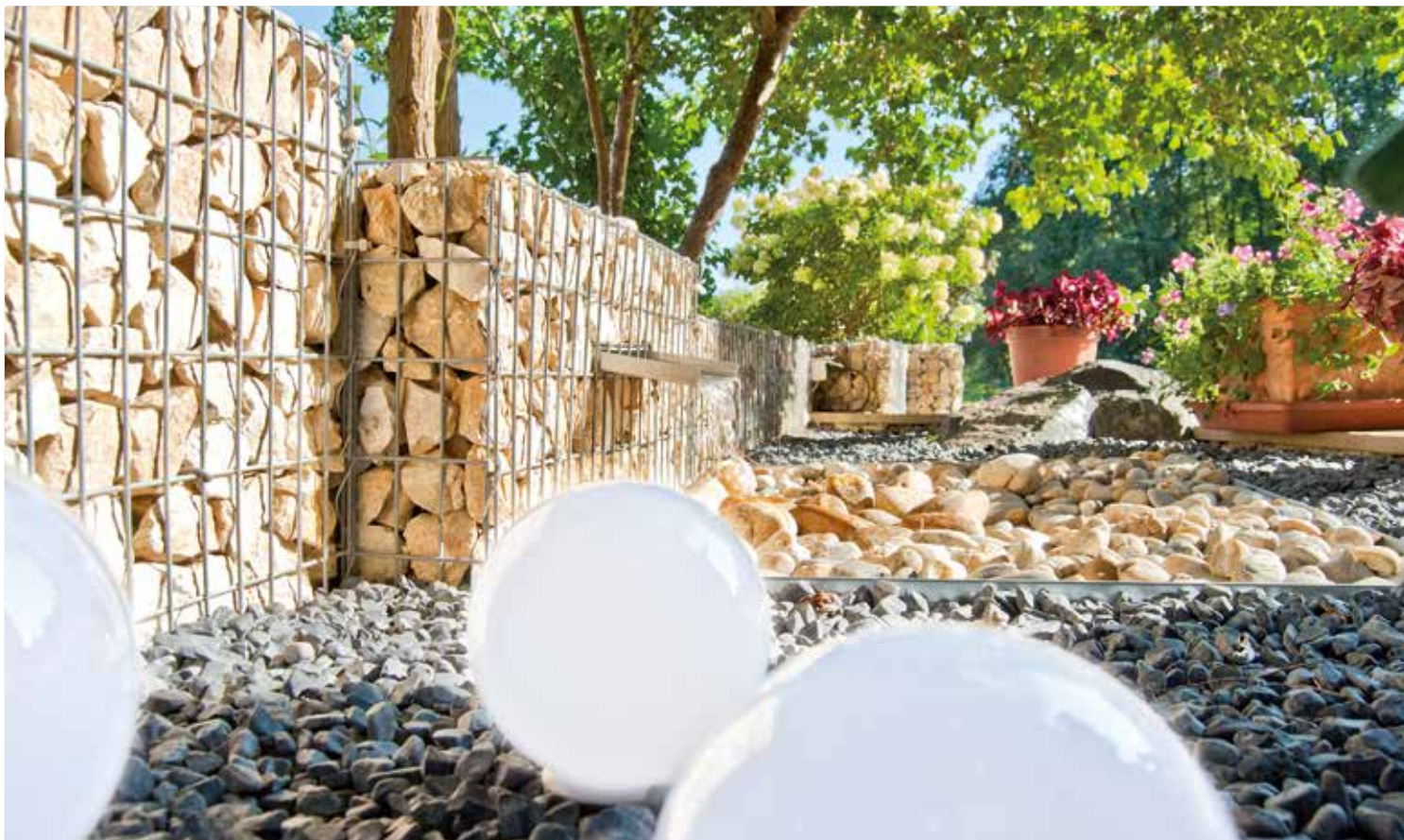
Vlastnoručně vyrobené gabiony se spirálovým spojem
