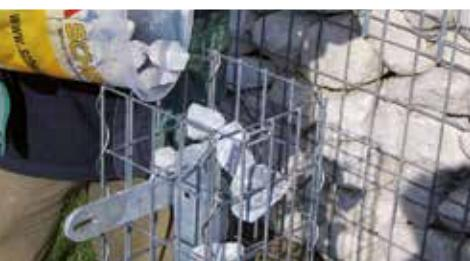
Po postavení konstrukce se gabiony plotu z vrchu naplní.
