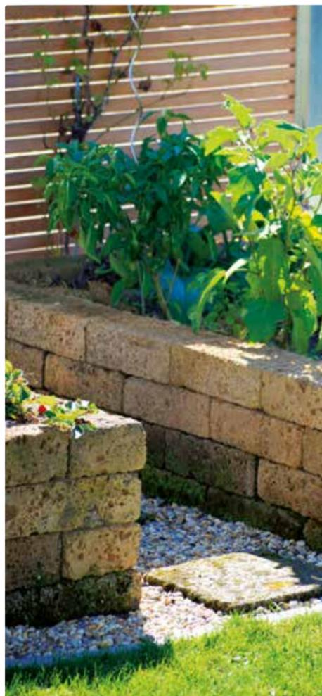
Tuffstein ist ein vulkanischer Naturstein und besteht aus Sand, Lava, Bimsstein und Asche. Er ist sehr porös und hat eine warme Ausstrahlung. Bereits die Römer setzten den Tuffstein zum Bau von Villen, Bädern und Thermen ein. Im Mittelalter wurden damit Burgen und Städte gebaut. Heute wird er als Baustein in der Gartengestaltung verwendet:
