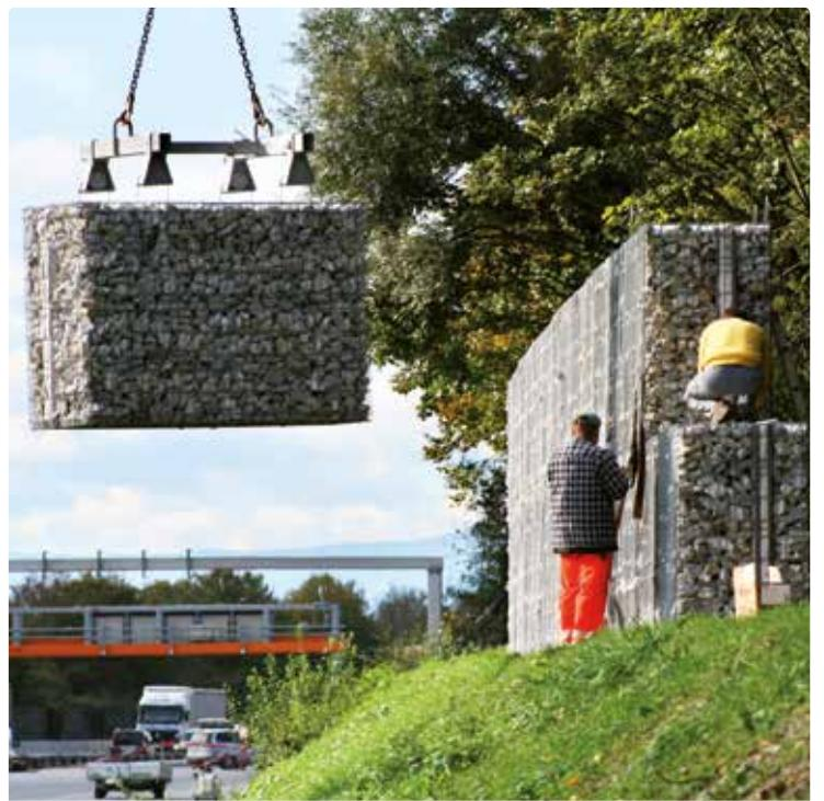
Gabioni ispunjeni samo kamenjem ne pružaju učinkovitu zaštitu od buke. Za ispunjavanje specifikacija zaštite od buke potrebno je ugraditi jezgru za zaštitu od buke u kamenu košaru.
