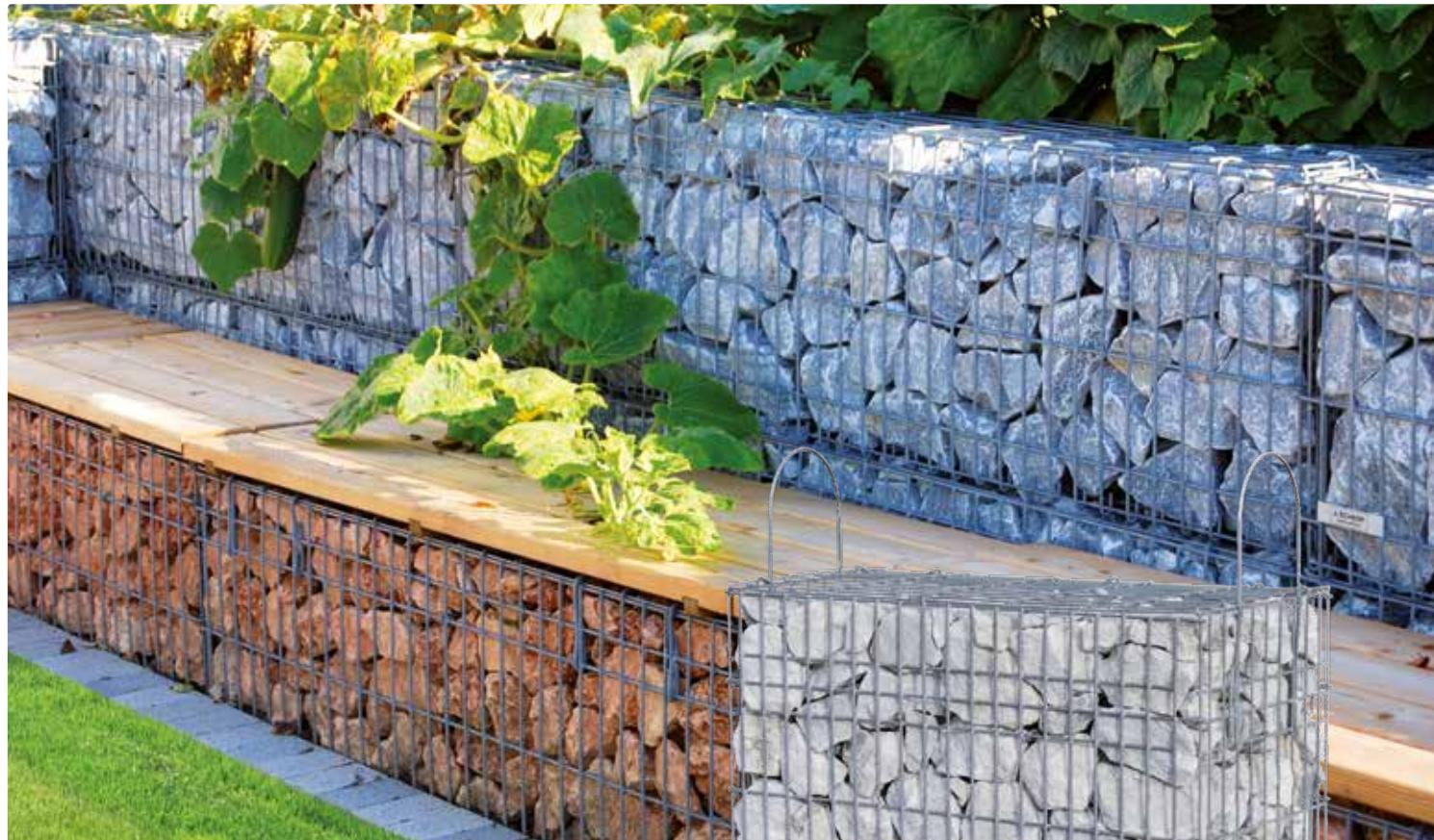
Veće kamenje ispune postavljeno je ravnom stranom prema mrežici. S ovim zahtjevnim ručnim radom, izgled košara podsjeća na kiklopski način gradnje antičkih zidina. Cijena se temelji na površini u m<sup>2</sup>. Svaka vidljiva površina može se oblikovati po principu ručno slagane površine.
