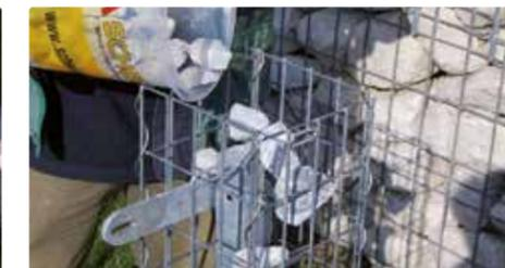
Nach dem Aufbau wird die Zaun-Gabione von oben befüllt.
