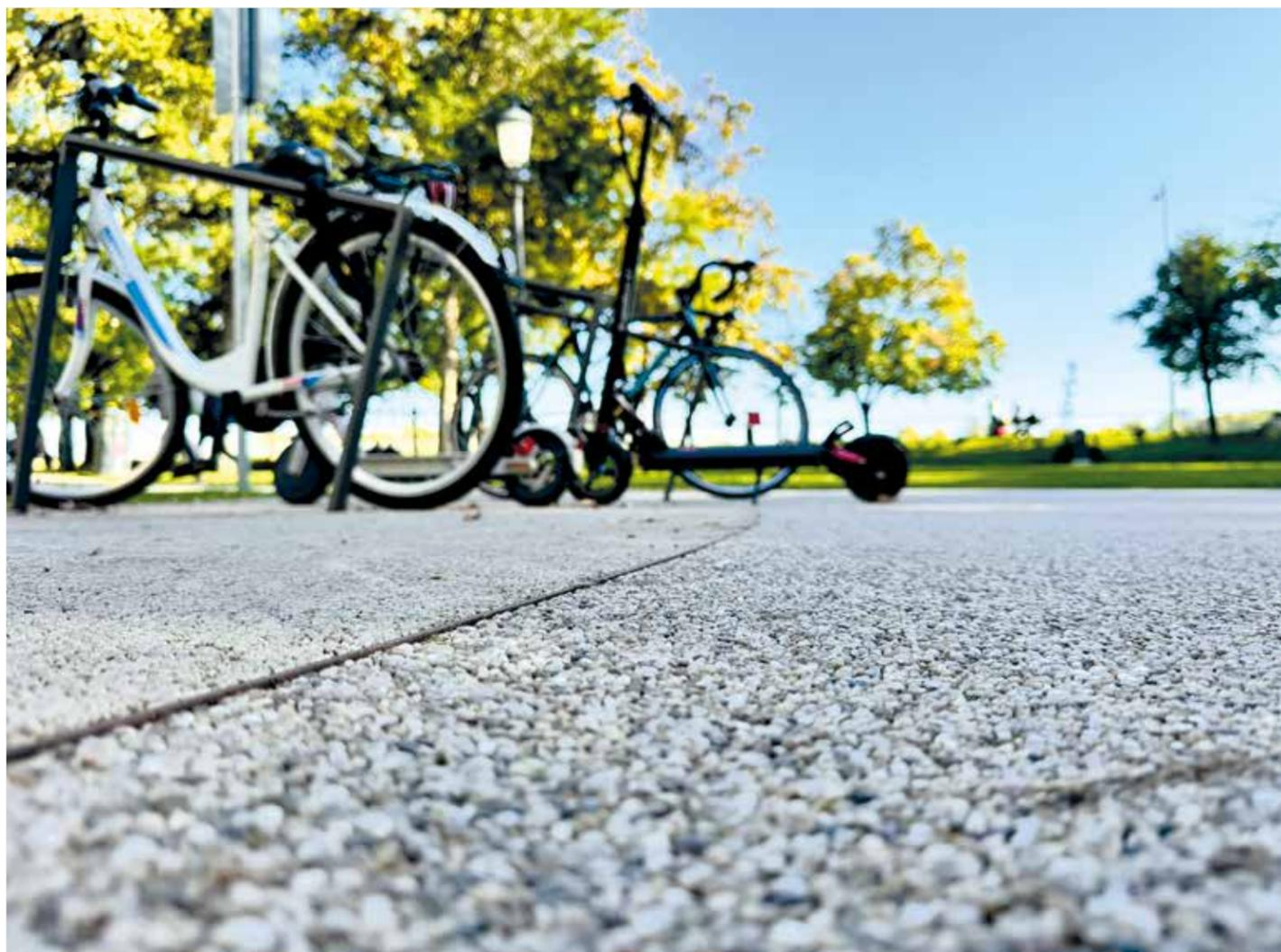
Quarkiese und Hartgesteinssplitt für die Herstellung von harzgebundenen, strapazierfähigen, wasserdurchlässigen und dekorativen Bodenbelägen im Innen- und Außenbereich.
