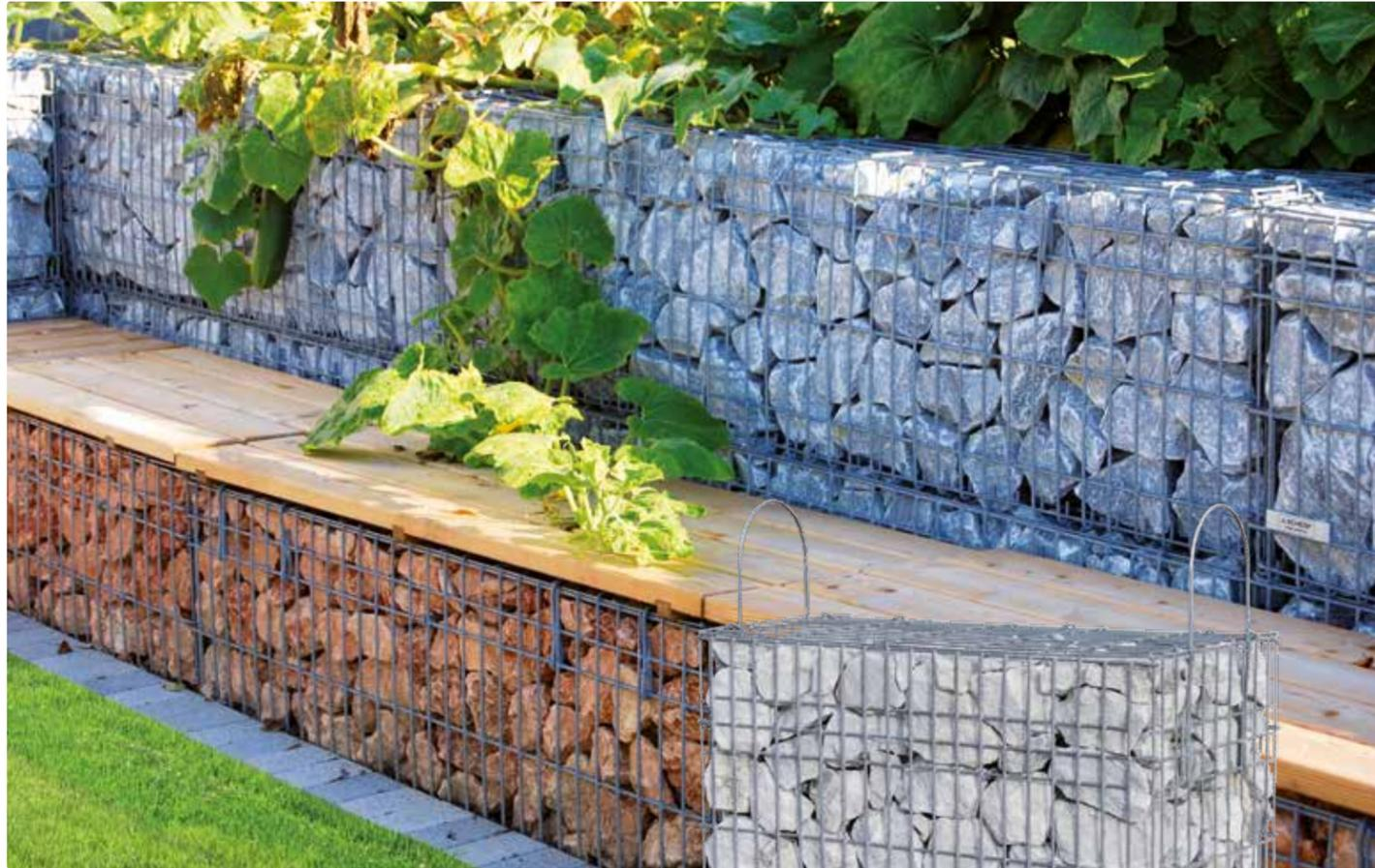
Die größeren Steine des gewählten Füllmaterials werden mit der flachen Seite am Gitter ausgerichtet. Durch diese anspruchsvolle Handarbeit erhält der Steinkorb die Optik eines engfugigen Zyklopenmauerwerkes. Die Berechnung erfolgt als Aufpreis pro m<sup>2</sup>. Jede Fläche kann als handgerichtete Sichtfläche ausgeführt werden.
