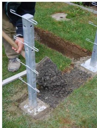
Bild: Verfüllen der Sauberkeitsschicht
