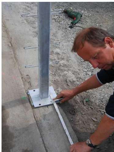
Bild: Kennzeichnung der Steher am Fundament
