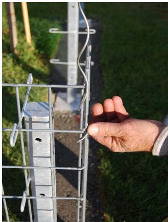
Bild: Eindrehen des Spiraldrahts
