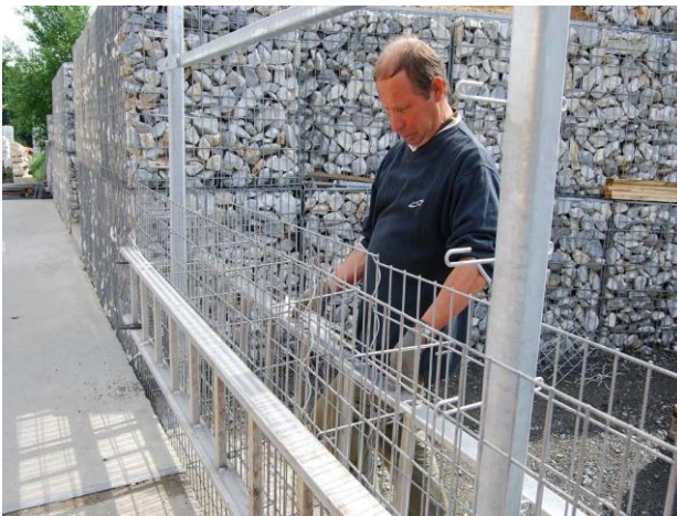
Bild: Befestigung von Leitern als Einfüllhilfe
