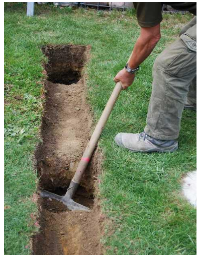
Bild: Aushub der Punktfundamente und der Sauberkeitsschicht
