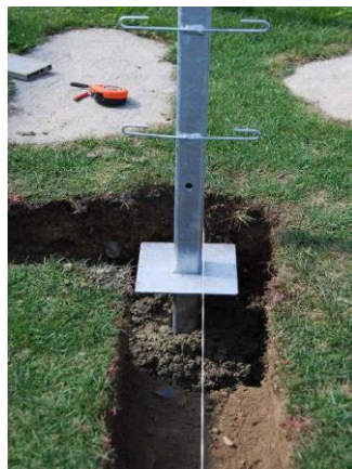
Bild: Ausrichtung mittels Schnur
