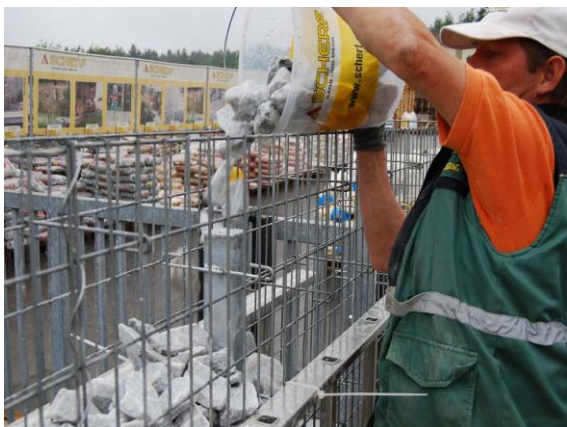
Bild: Befüllen der Gabione
