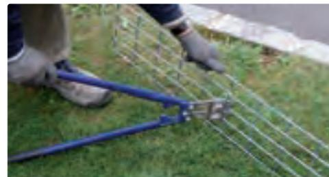
Die Zaunlänge ist durch einfaches Abwickeln der Matten in 5 cm Schritten anpassbar. Standardlängen: 30/50/100/150/200 cm
