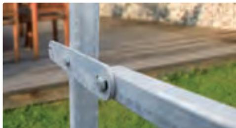
Die Laschen mit Querriegel befinden sich „unsichtbar“ zwischen dem Füllmaterial und gewährleisten höchste Stabilität.
