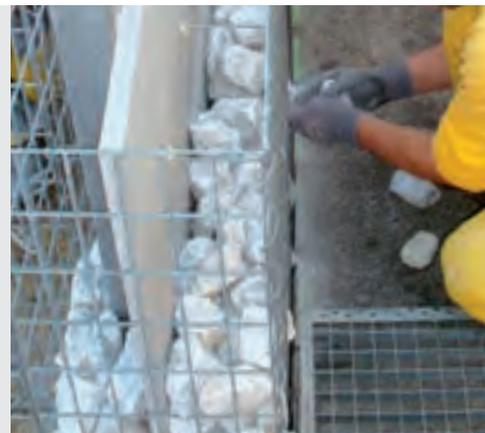
**VARIANTE 3****Lärmschutzkassette zum Einschieben in HEA-Stahlstützen**
