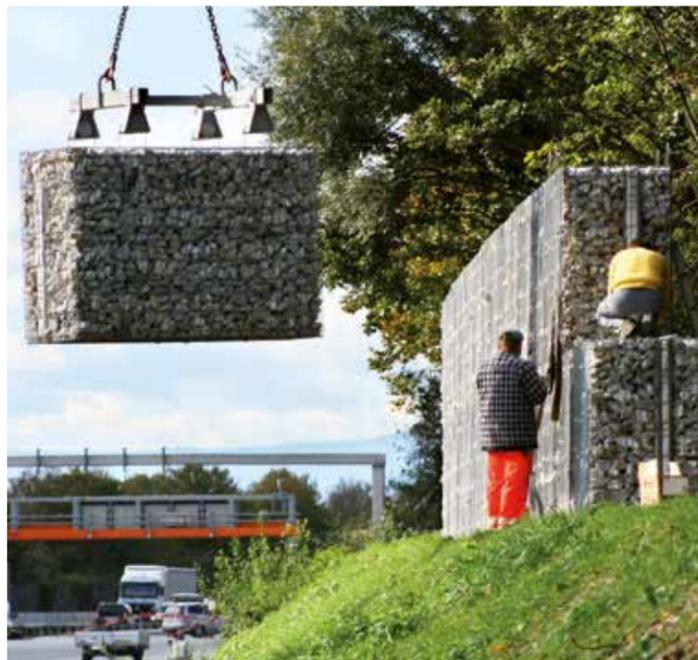
Gabionen, die ausschließlich mit Steinen befüllt sind, gewähren keinen effektiven Lärmschutz. Um die in den Normen geforderten Lärmschutzwerte zu erfüllen, ist der Einbau eines Lärmschutzkerns in den Steinkorb erforderlich. Dieser von Steinen umgebene Lärmschutzkern ist unsichtbar im Korb positioniert und kann aus verschiedenen Materialien ausgeführt sein. In den letzten Jahren haben wir verschiedene hochwertige Lösungen konstruiert und realisiert.
