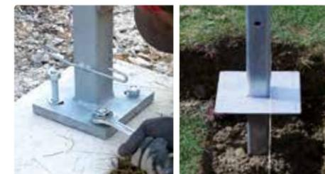
Zwei verzinkte Stehervarianten sorgen bei Höhen über 50 cm für die Standfestigkeit der Zaun-Gabione.
