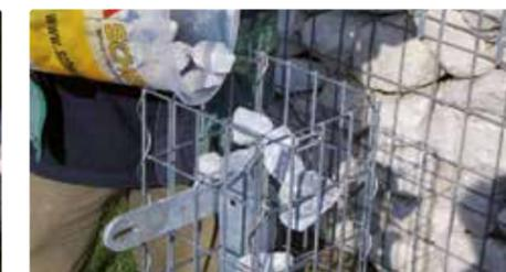
Nach dem Aufbau wird die Zaun-Gabione von oben befüllt.
