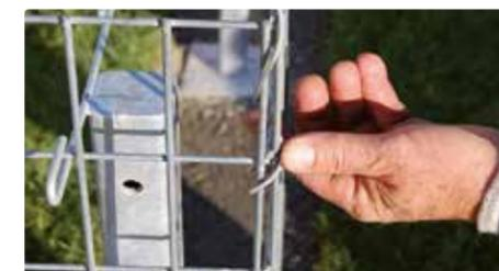
Der passgenaue Spiraldraht sorgt für saubere und exakte Eckverbindungen.
