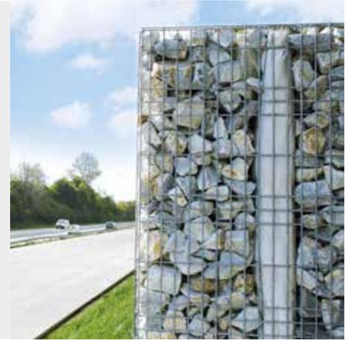
**VARIANTE 2****Selbstbau-Gabione mit Lärmschutzkit**
