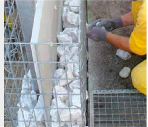
**VARIANTE 3****Lärmschutzkassette zum Einschieben in HEA-Stahlstützen**
