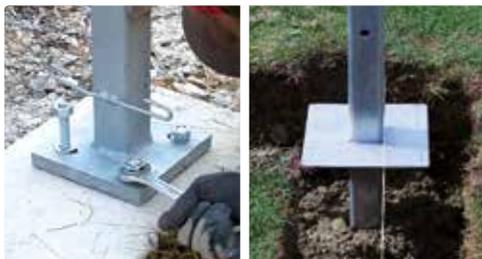
Zwei verzinkte Stehervarianten sorgen bei Höhen über 50 cm für die Standfestigkeit der Zaun-Gabione.
