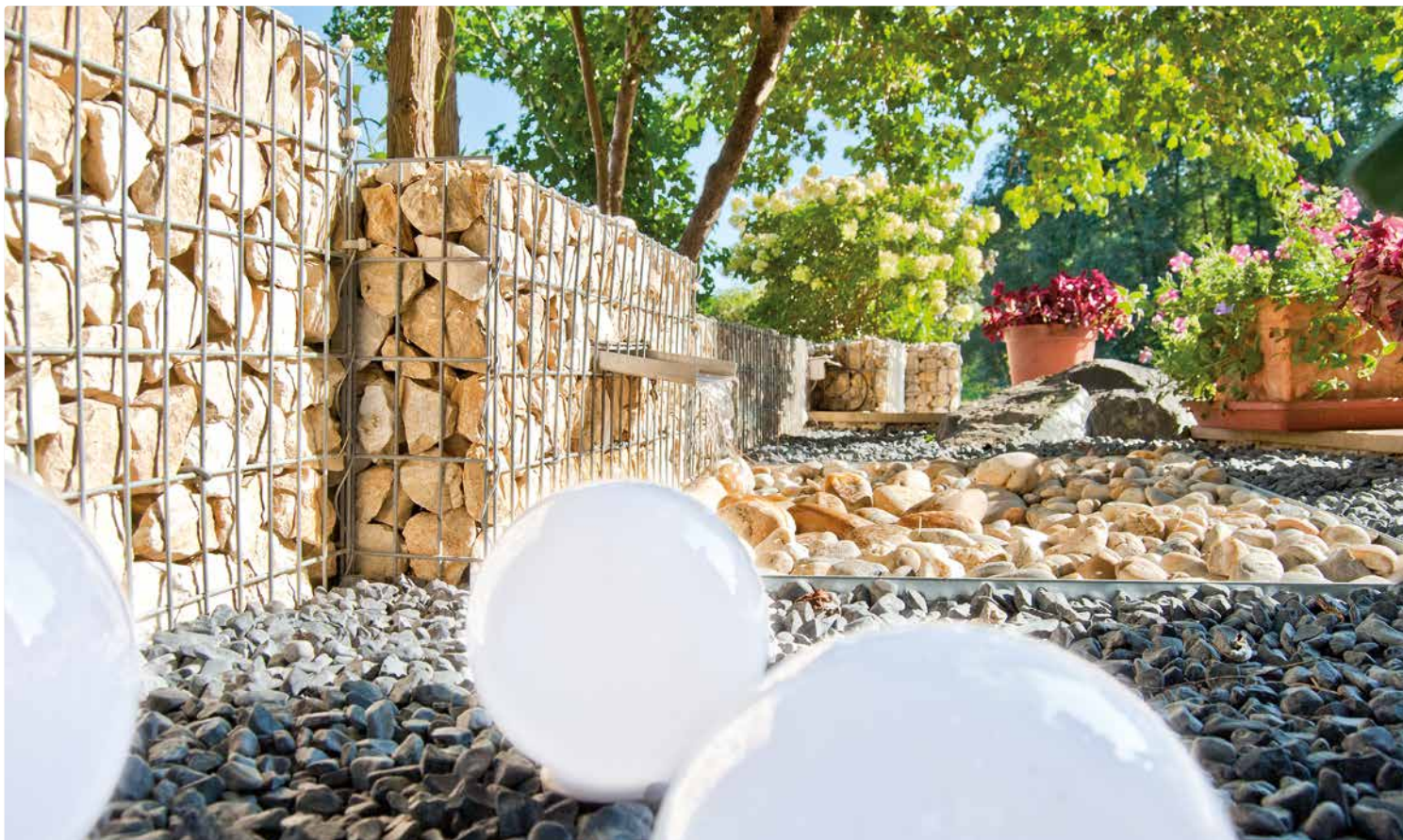
"Uradi sam" gabion sa spiralnom žicom
